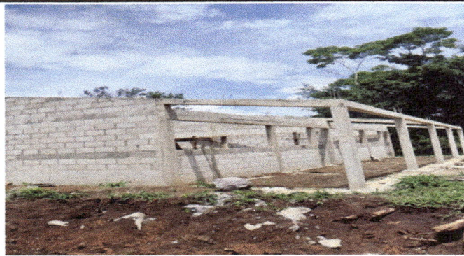
Foto 3: PARTE FRONTAL DEL MODULO 1, AULA 1, FINALIZACION DE COLOCACION DE BLOCK Y COLUMNAS
