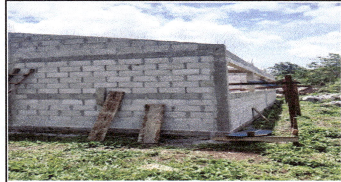
Foto 4: PARTE DE ATRÁS DE MODULO 1, AULA 2. FINALIZACION DE COLOCACION DE BLOCK.
