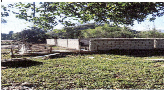
Foto1: AVANCE DE LA COLOCACION DE BLOCK DE 2 AULAS
