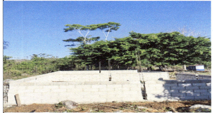
Foto 2: PARTE DE ATRÁS DEL AULA 1, AVANCE DE COLOCACION DE BLOCK
