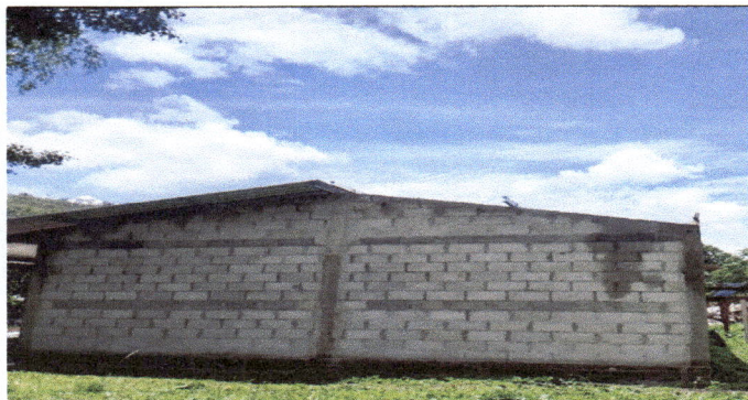
Foto 5: INICIO DE INSTALACION DE TECHO, TUBO., COSTANERA Y LAMINAS
