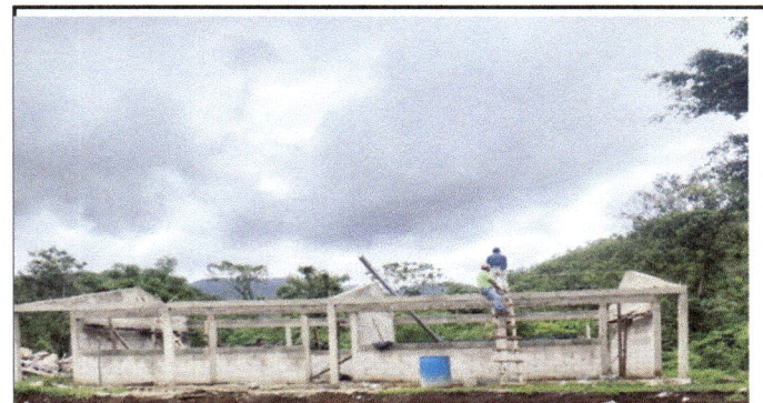
Foto 6: AVANCE DE COLOCACION DE CORREDOR
